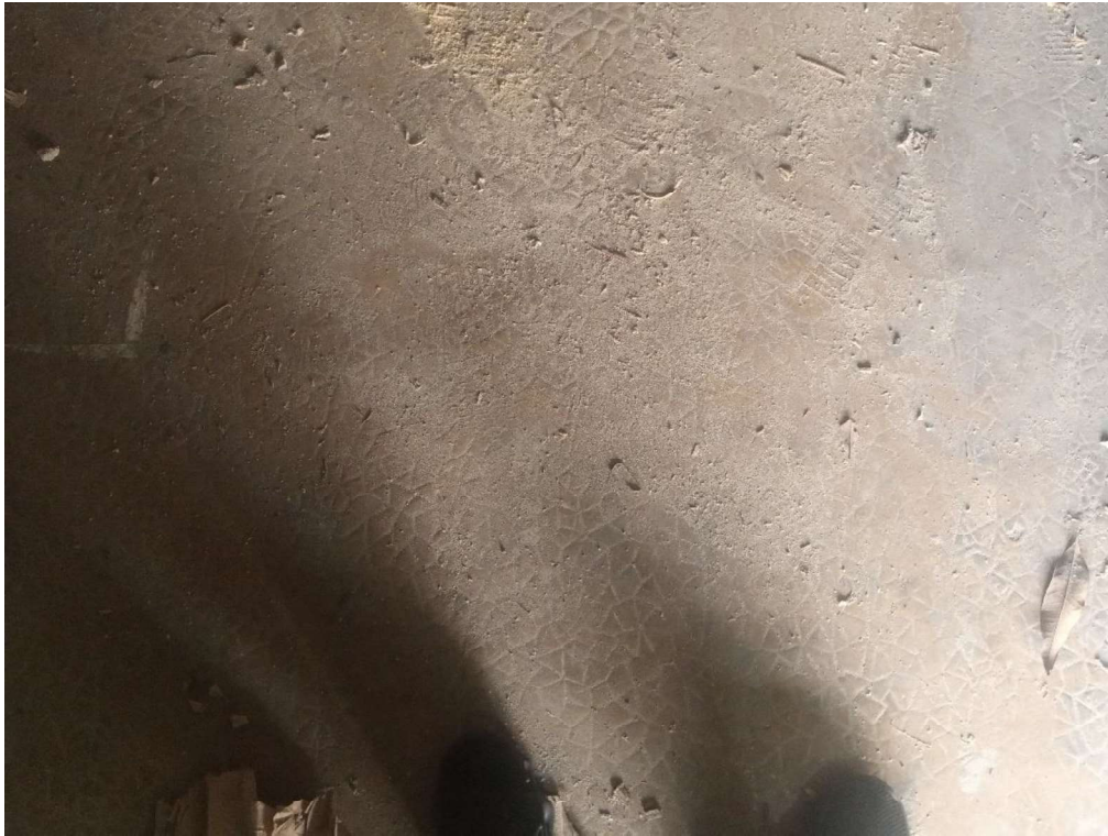
PHOTO-2 : VUE SUR LE SOL DU GARAGE DE L'APPARTEMENT N°2
