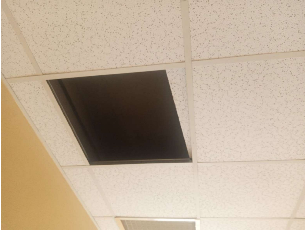
PHOTO-4 : VUE SUR L'UN DES PLAFONDS EN DALLE MINERALE
