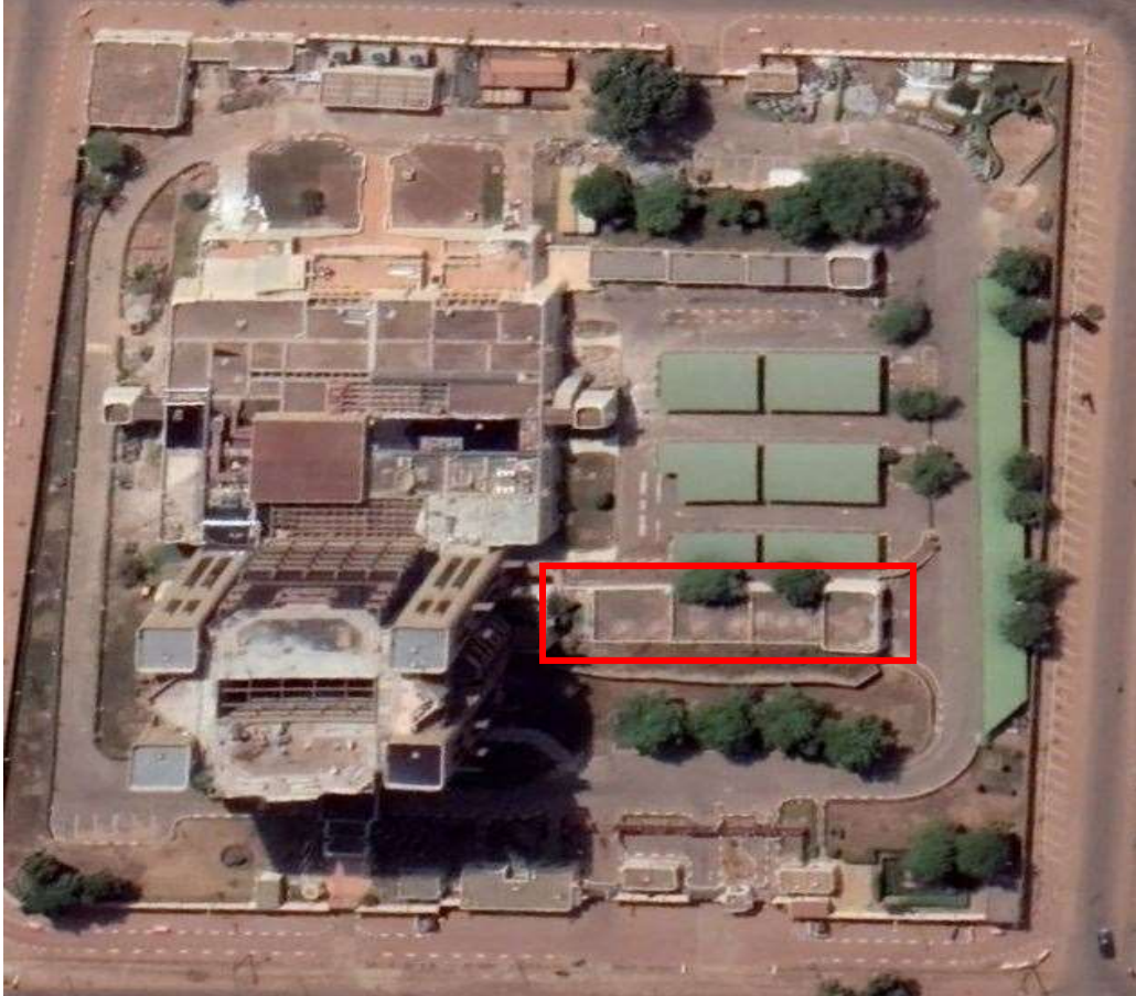
Figure 1 – Situation des panneaux de dalles dégradées
