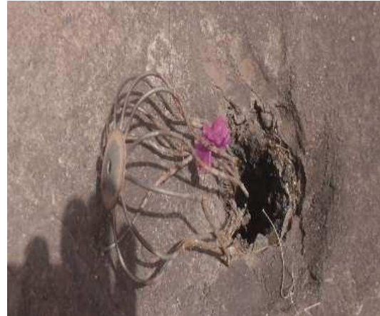
Photo 25 : Traitement sous dalle mal fini
