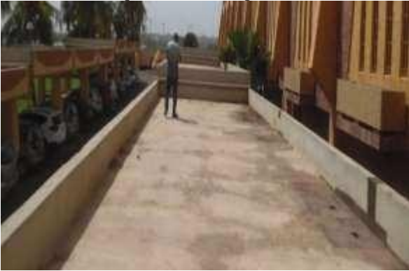
Photo 10 : Manque de forme de pente, couronnements/becquets périphériques et stagnation d'eau sur toiture
