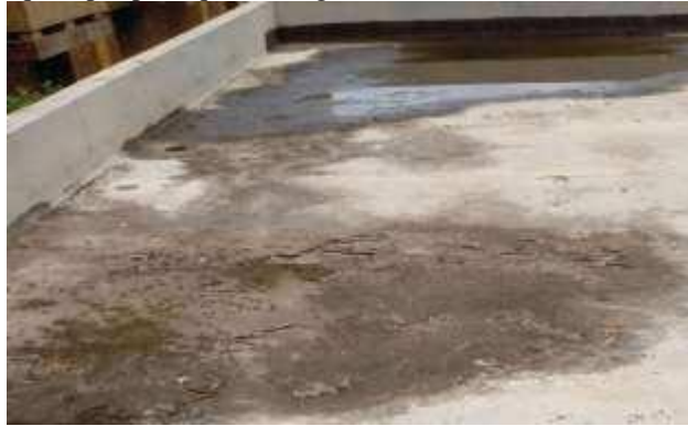
Photo 10 : Manque de forme de pente, couronnements/becquets périphériques et stagnation d'eau sur toiture
