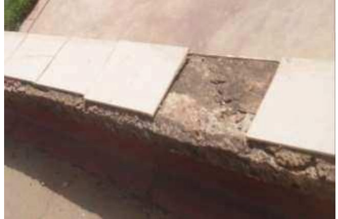
Photo 20 : Etanchéité bicouche (fissures sur la dernière couche)
