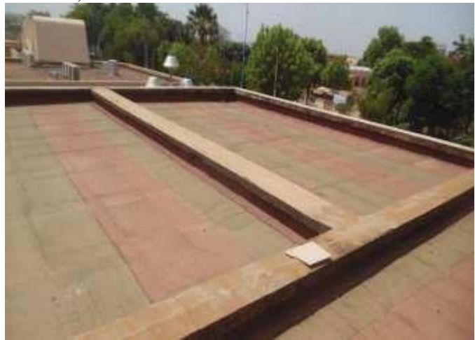
Photo 20 : Etanchéité bicouche (fissures sur la dernière couche)
