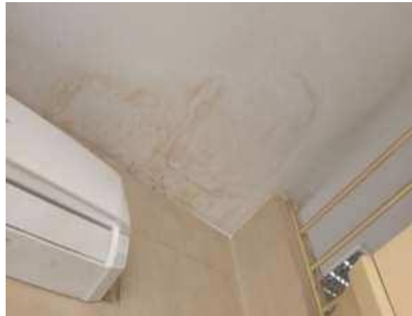
Photo 25 : Traitement sous dalle mal fini
