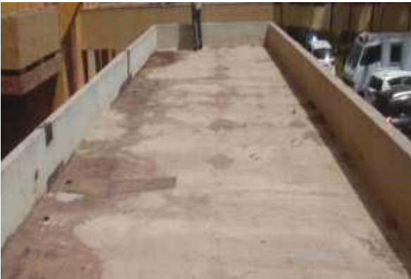
Photo 11 : Fissuration sur les murs des acrotères et sur la toiture/Dessente d'eau sans crapaudines
