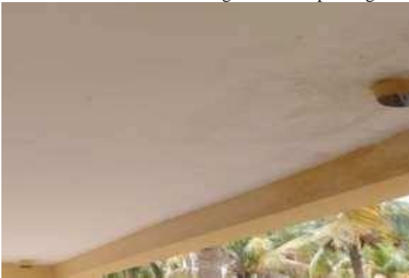
Photo 12 : Descentes d'eau dirigées dans le parking
