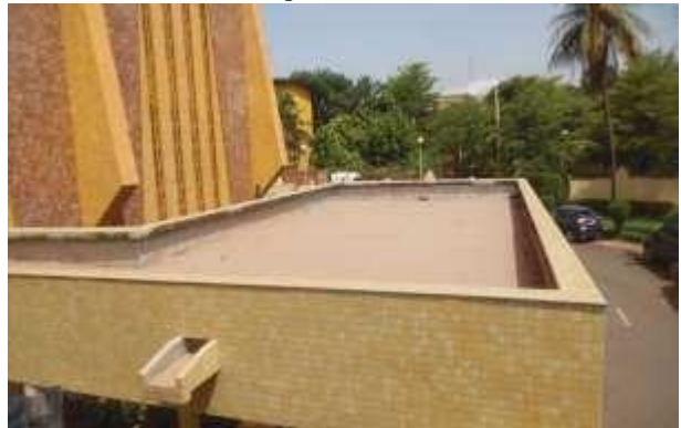
Photo 15 : Becquet réalisé sur les acrotères
